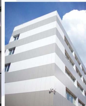
Компания изготовила на собственном производстве и выполнила монтаж кассетного вентилируемого фасада «QUANTUM®» в объеме 2000м<sup>2</sup>.
