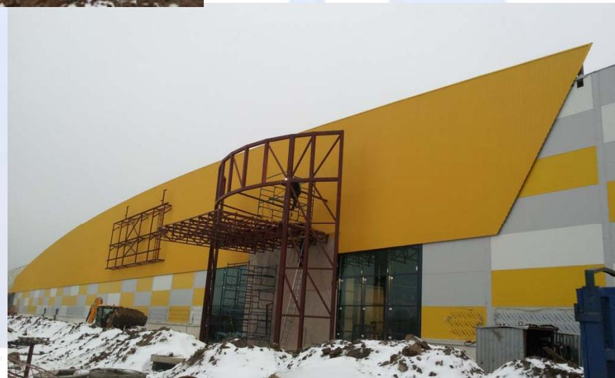
Устройство фасадных систем: Декоративный элемент из волнообразного профилированного листа, кассетные фасады из композитных панелей. Устройство входных групп.
